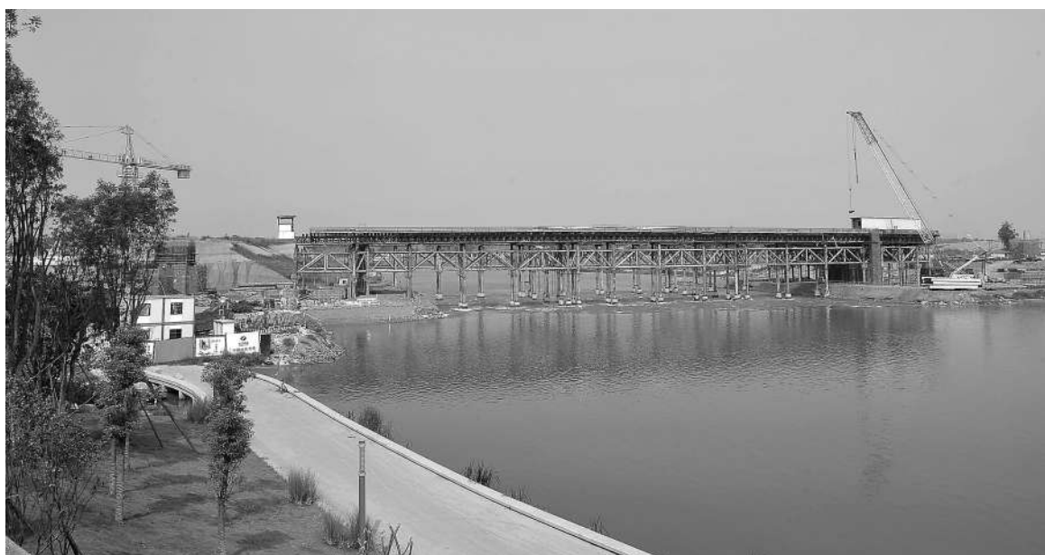
紧张施工中的云龙湾大桥项目工地
