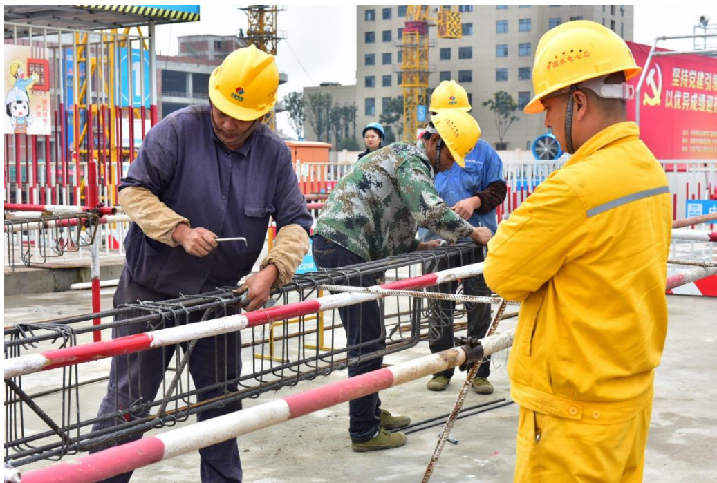
钢筋工技能大赛紧张比拼中
